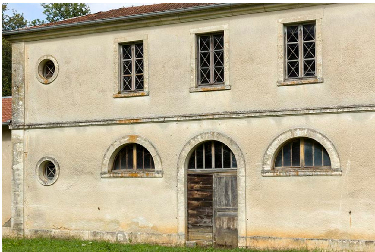
Etable : vue générale de la façade sud-ouest.
