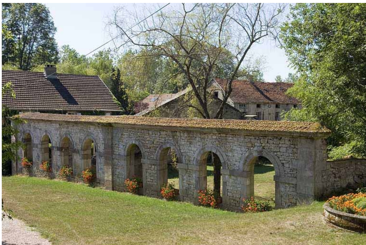
Vestiges de l'atelier de fabrication. Mur nord.
