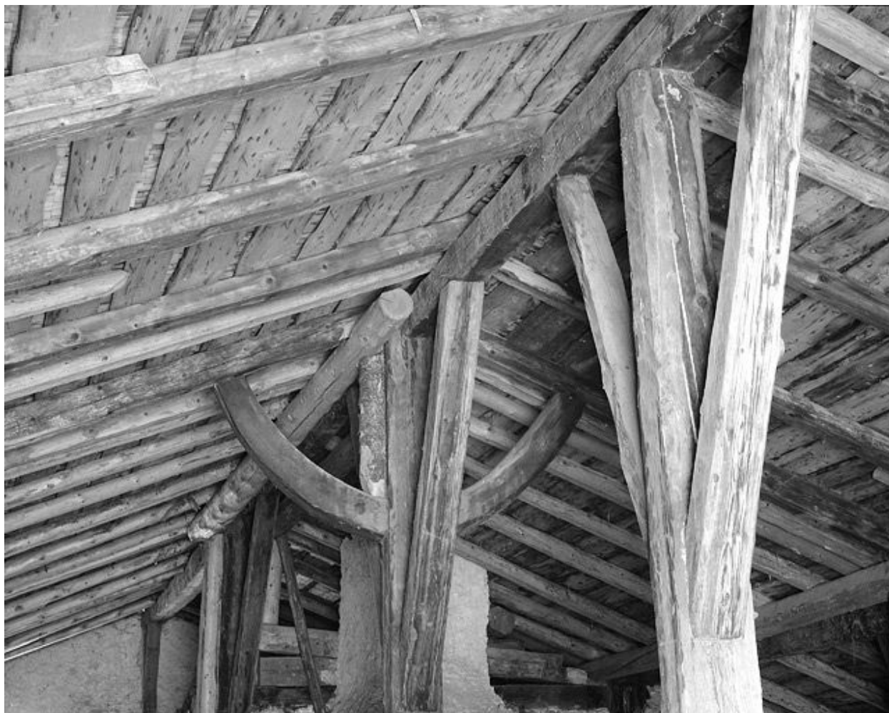
Charpente, colonne sous faîtage et contrefiche.
