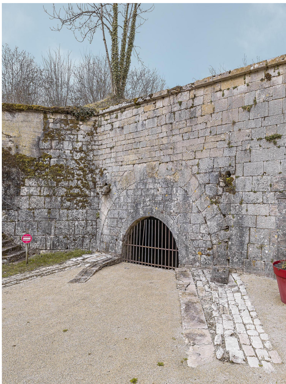
Casemate "époque Vauban".
