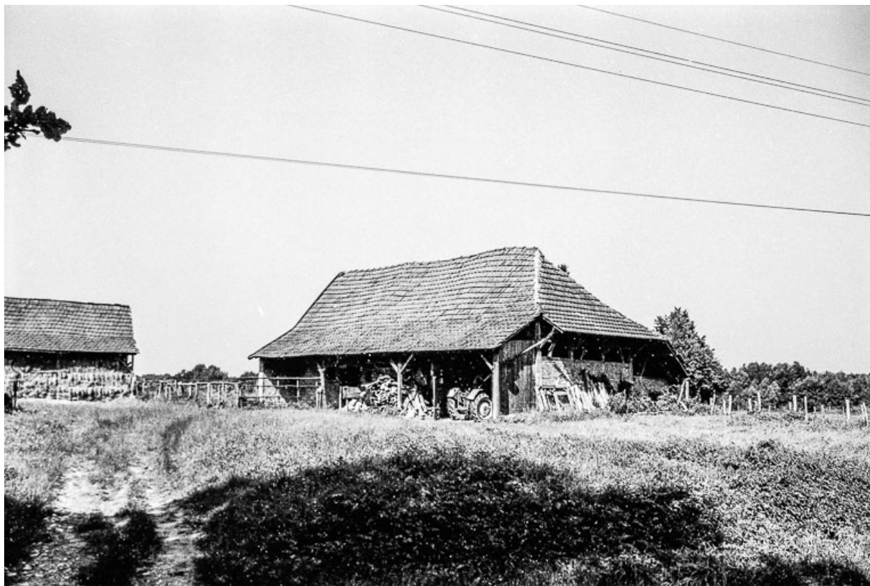
Façade postérieure d'une ferme.
