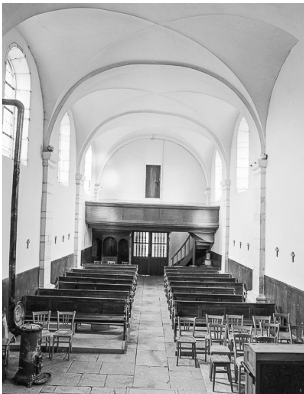
Intérieur : nef depuis le chœur.
