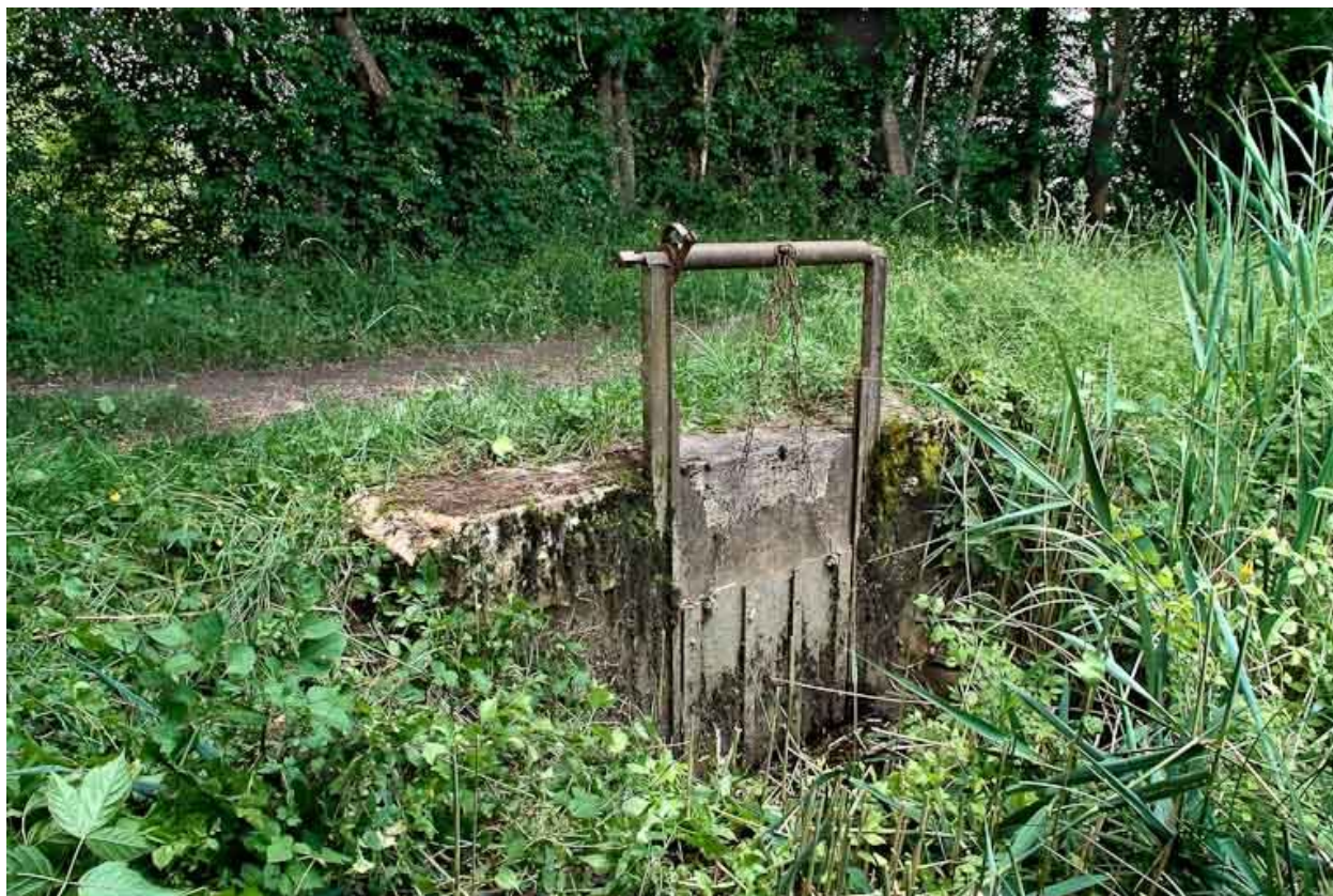
Vue rapprochée de la vanne de l'aqueduc.
