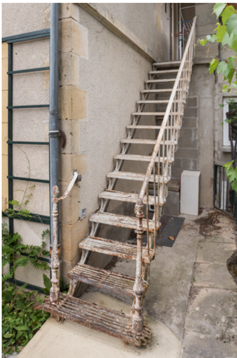
Escalier extérieur conduisant à l'étage.
