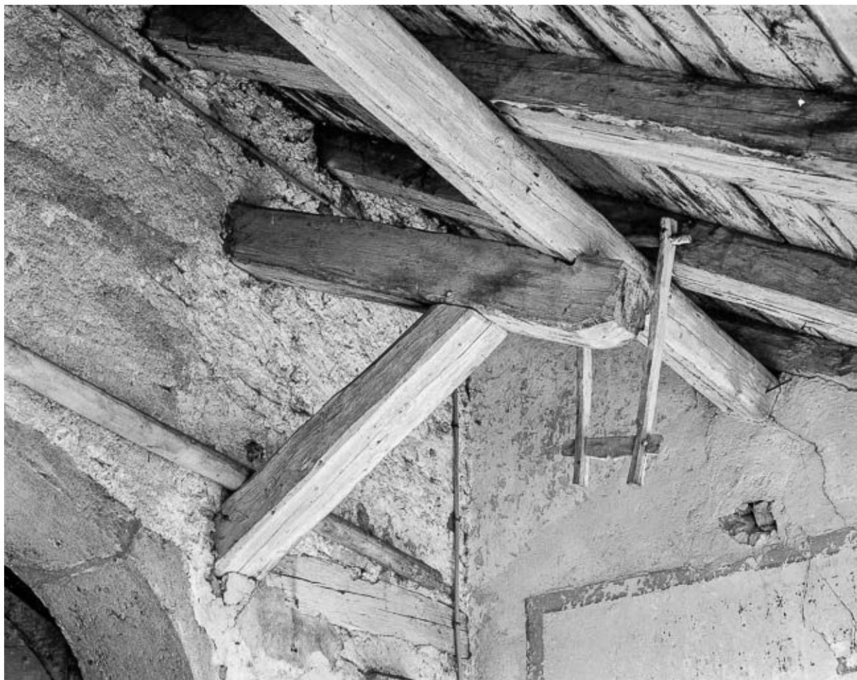
Auvent sur gutterot, côté droit.
