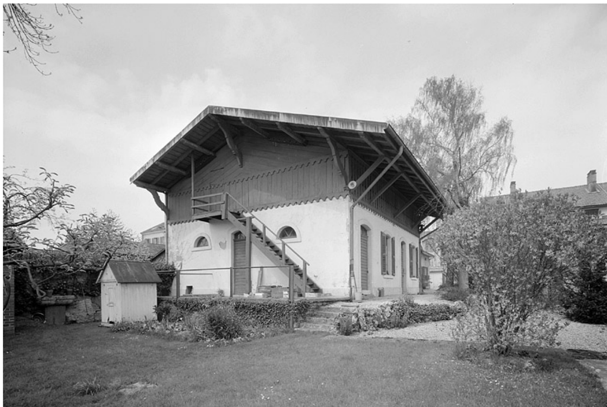
Remise à voitures. Façades sud et est.
