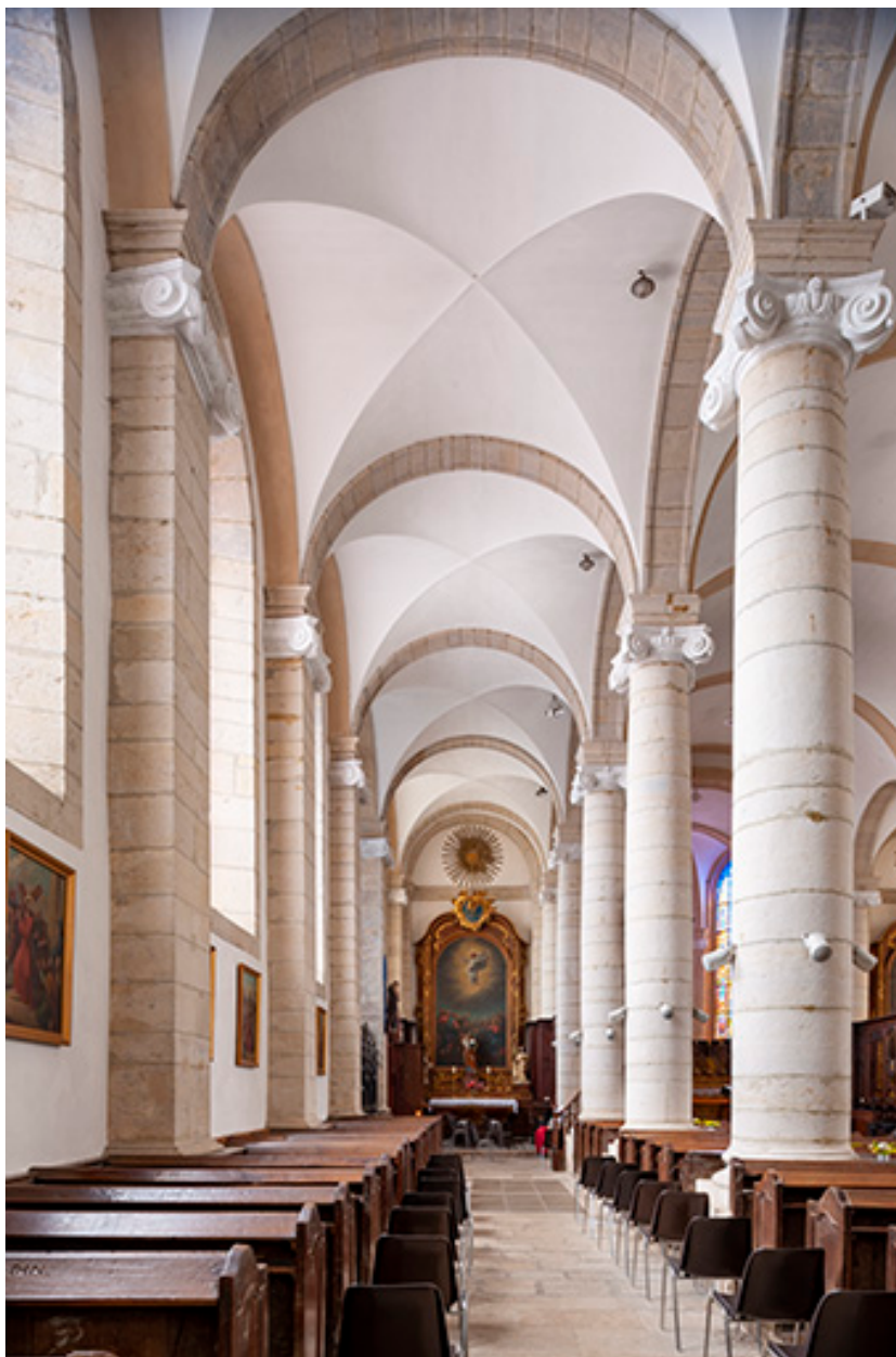
Le collatéral gauche depuis l'entrée.
