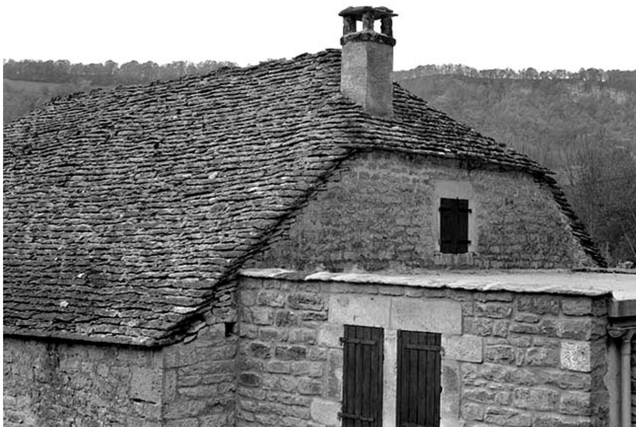
Détail d'une toiture en laves.
