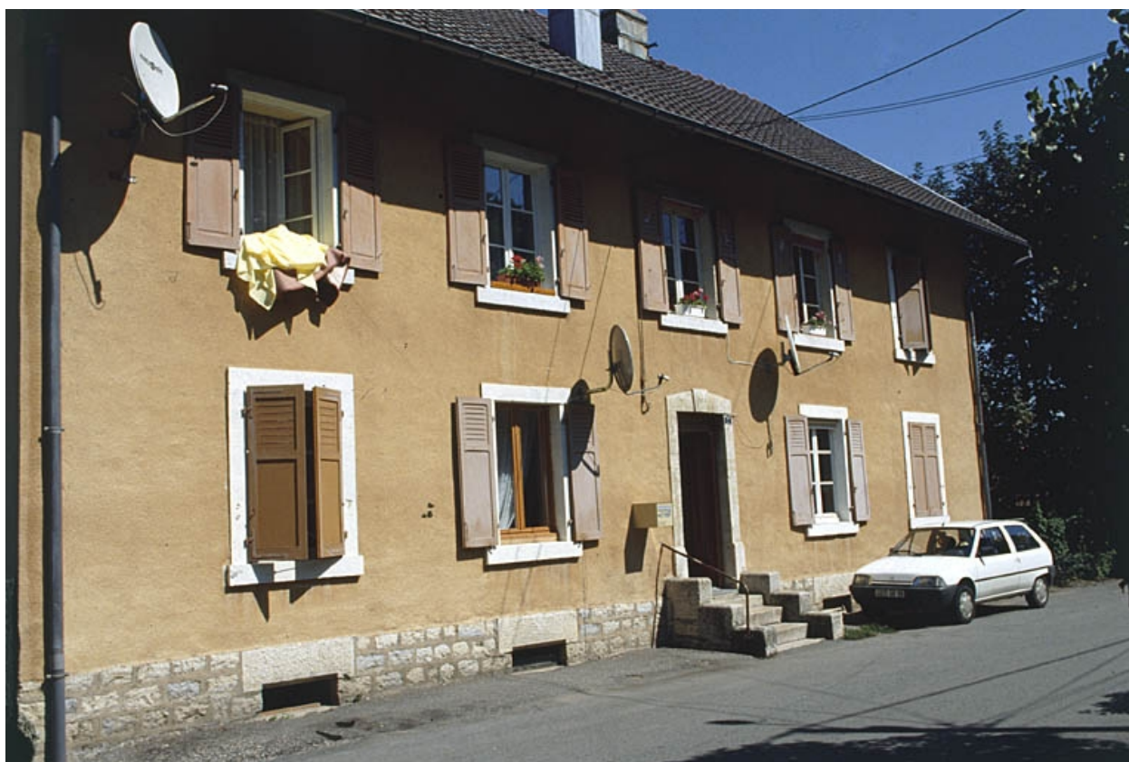
Façade antérieure d'un logement ouvrier à 4 appartements.
