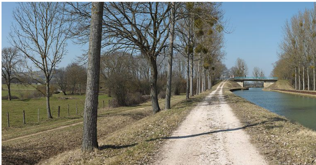
Vue d'ensemble du pont.
