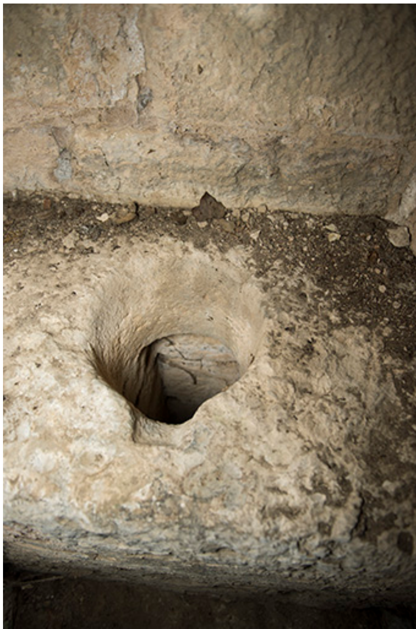
Dans la tour ouest. Détail de latrines.
