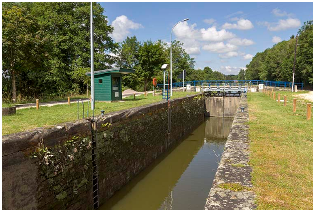
L'écluse et son poste de commande.
