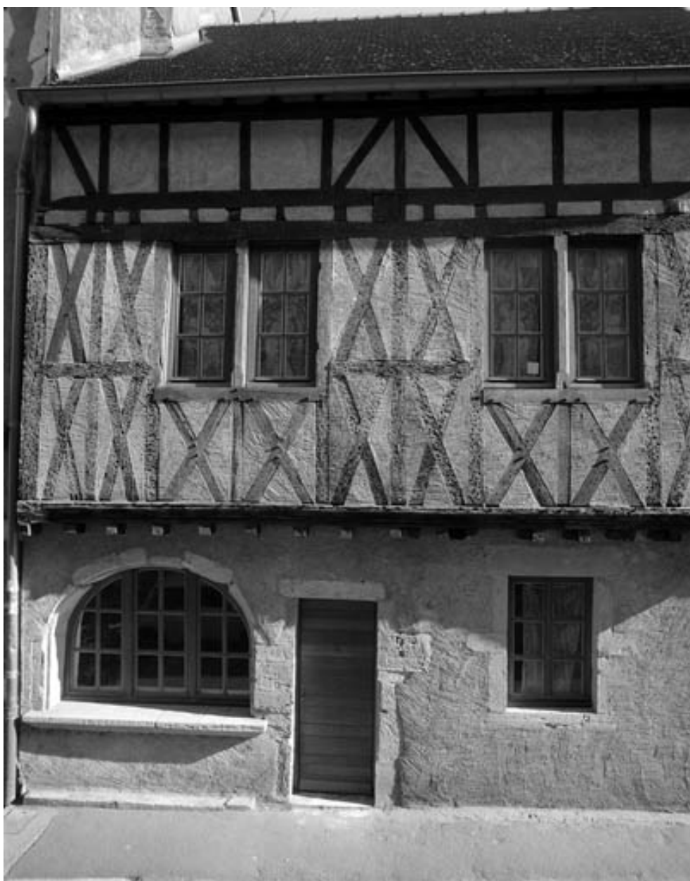
Façade antérieure : détail des pans de bois.
