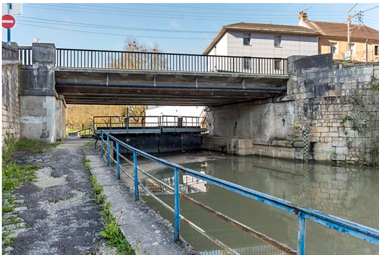
La porte de garde, vue depuis l'amont.
