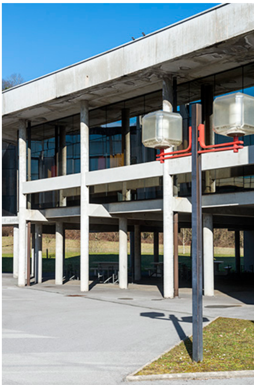
Détail de préau sous le bâtiment d'accueil.
