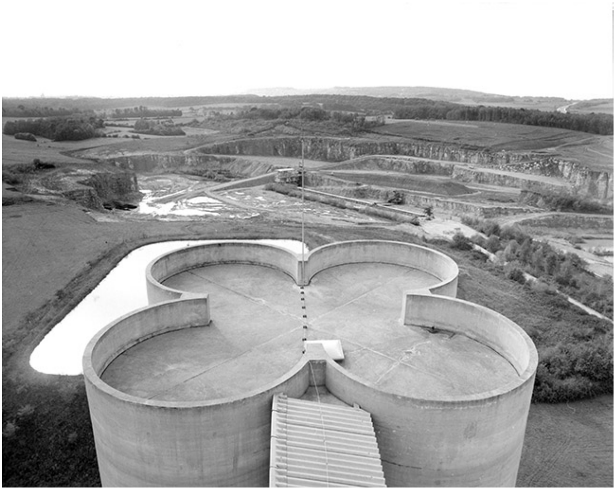
Cimenterie de la S.A. Ciments de Champagnole, Rochefort-sur-Nenon : silos et carrière.
