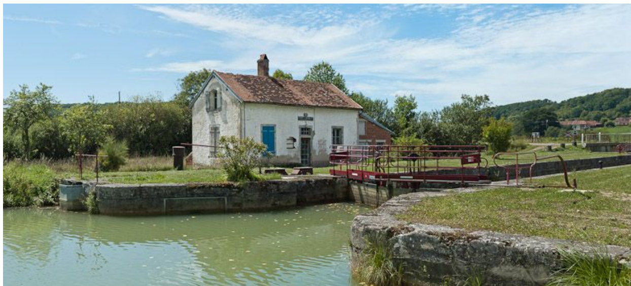
Vue d'ensemble du site d'écluse.
