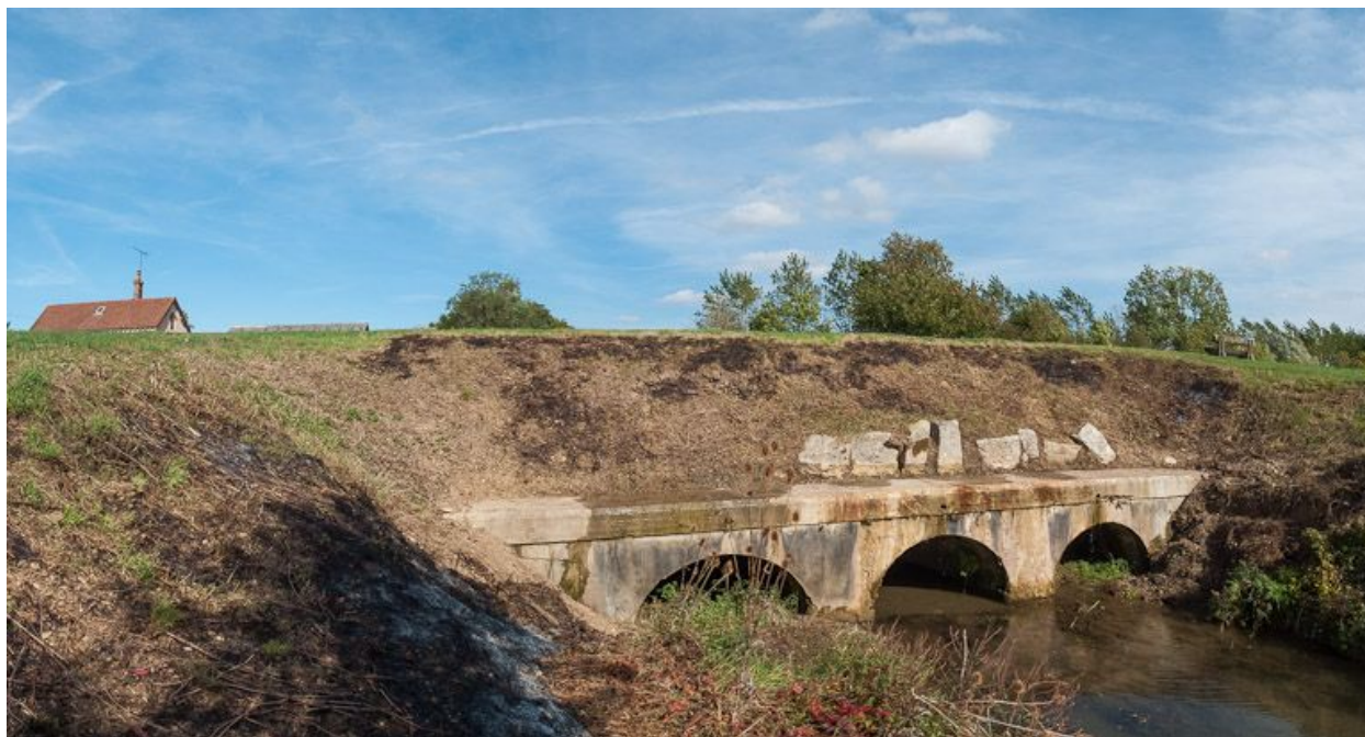
Aqueduc en amont du sas.
