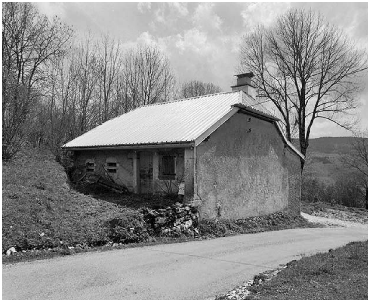
Façade antérieure et face droite.
