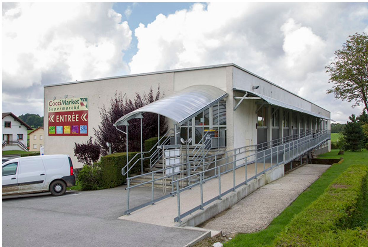
Façades latérale droite et postérieure.
