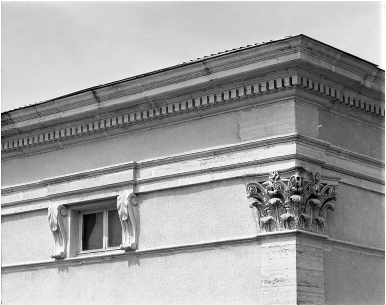
Façade antérieure : détail de l'attique.
