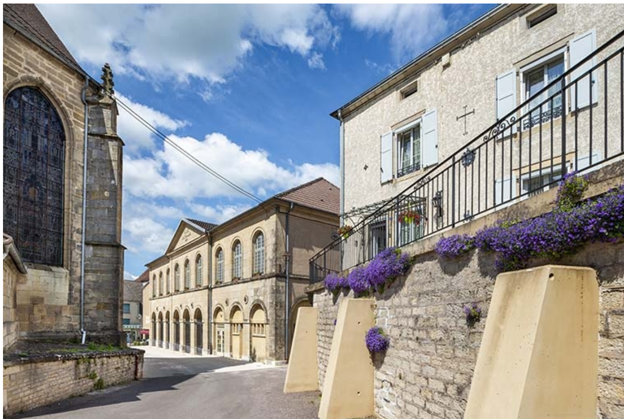
Vue éloignée depuis le sud.
