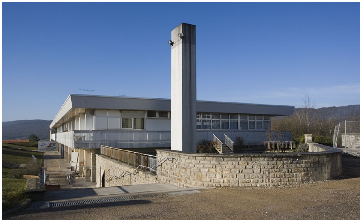
Internat : vue d'un pignon.
