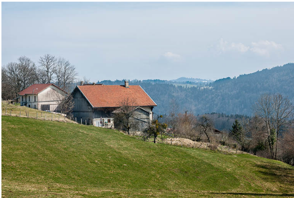
Garage, ferme et logement, depuis l'ouest.
