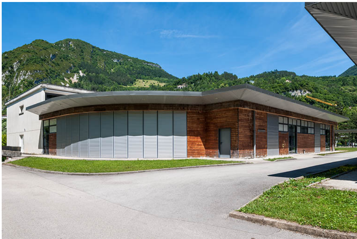
Extension de l'externat : façades.
