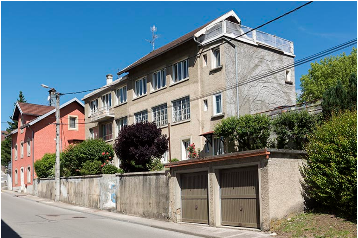
Façades sud et est.
