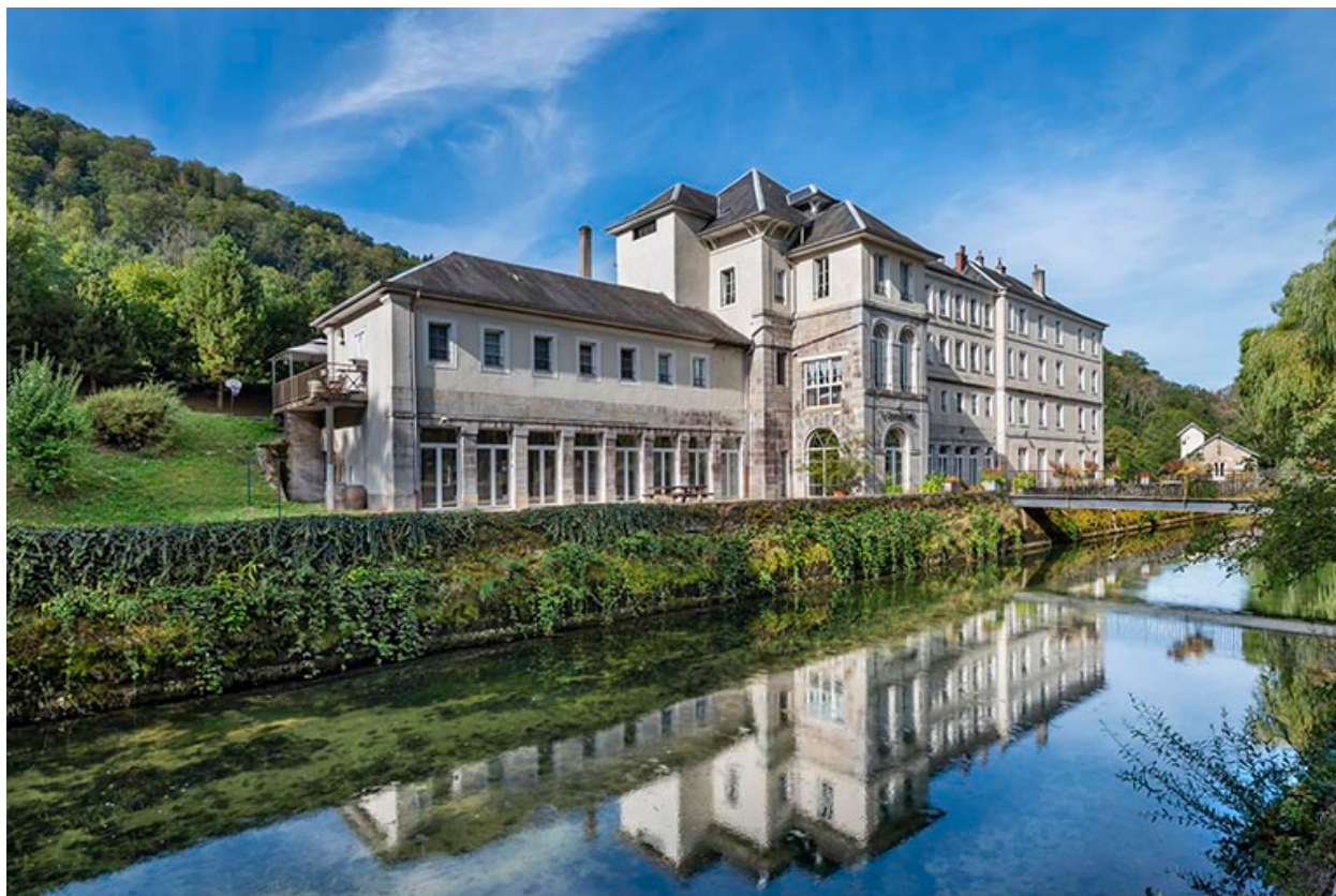
Façade principale, vue de trois quarts.
