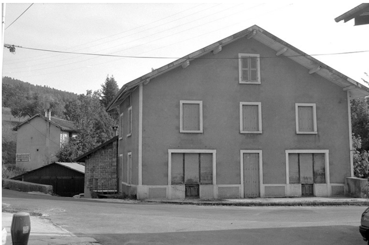
Façade antérieure du logement.
