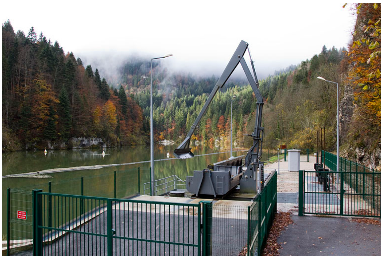
Prise d'eau : vue d'ensemble.
