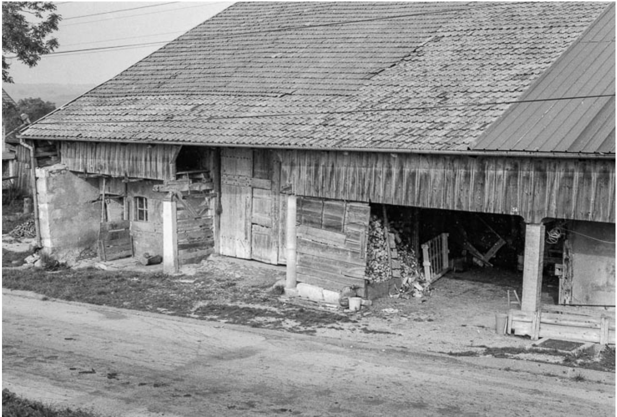
Façade latérale gauche sur rue : partie gauche.
