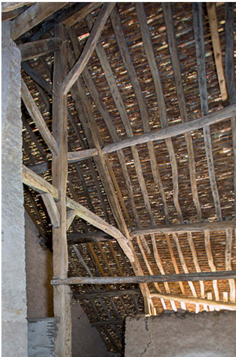
Intérieur : détail de la charpente.
