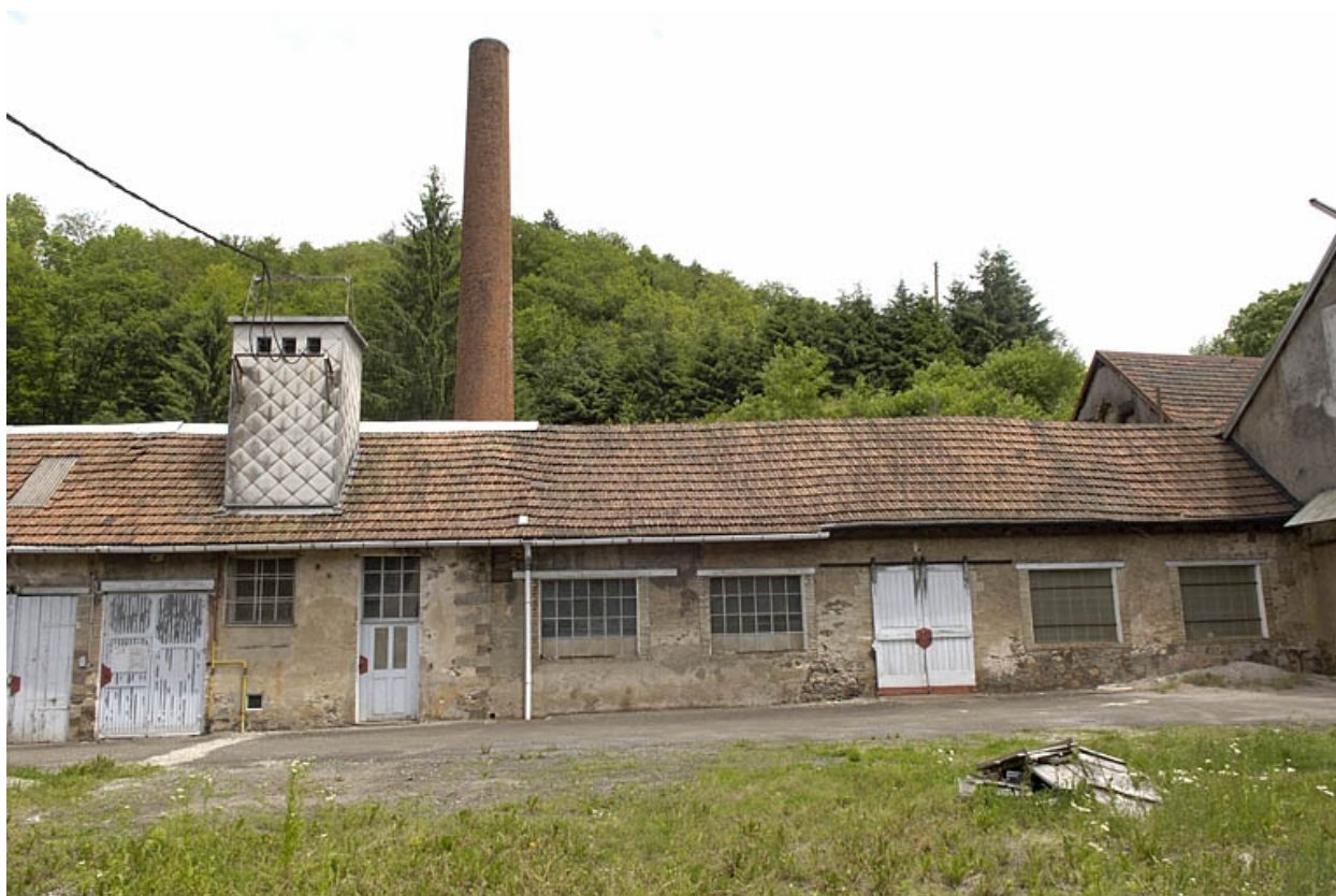
Façade sud-ouest de l'atelier de polissage.
