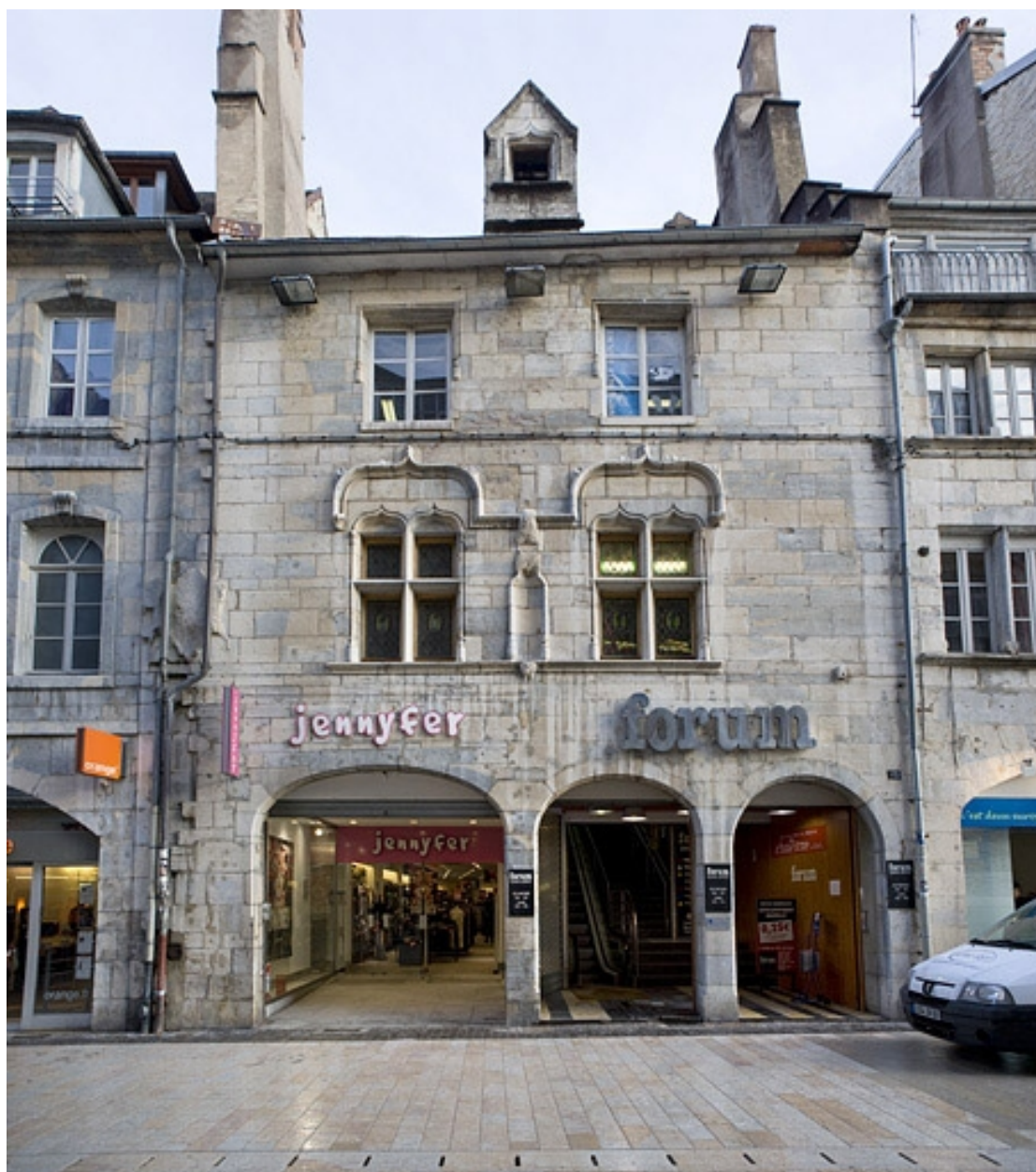
Façade antérieure du 15 Grande Rue : de face.
