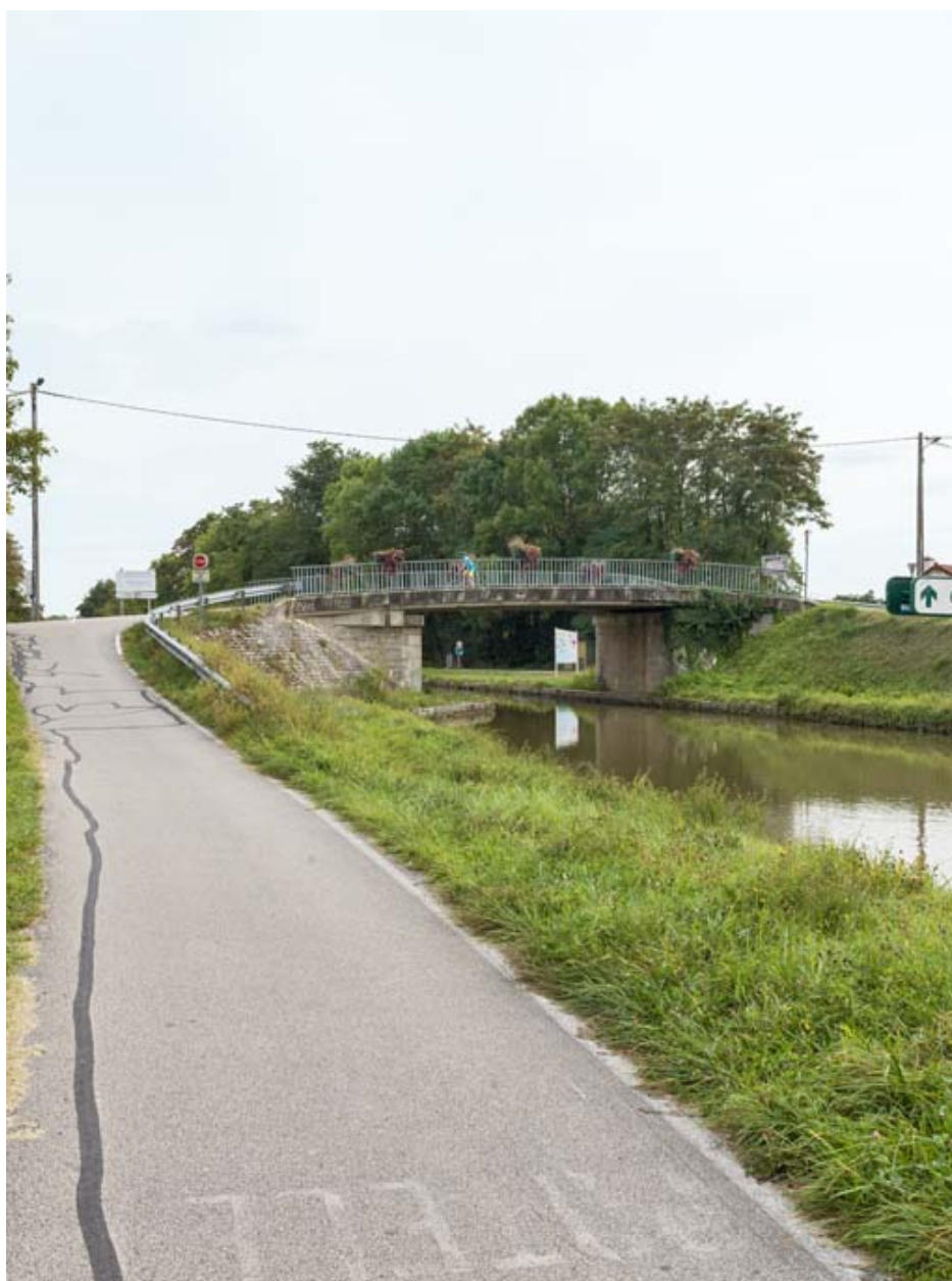
Vue d'ensemble du pont.
