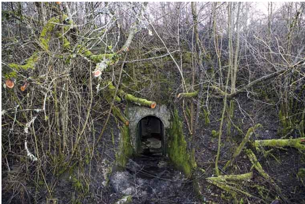
Réservoir, Pâtur de Montsevely : aqueduc d'évacuation.
