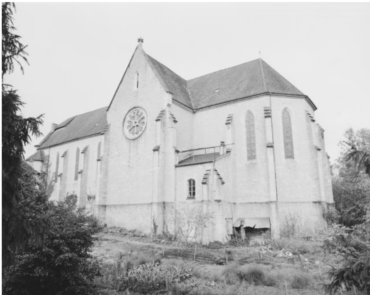
Façade latérale droite.
