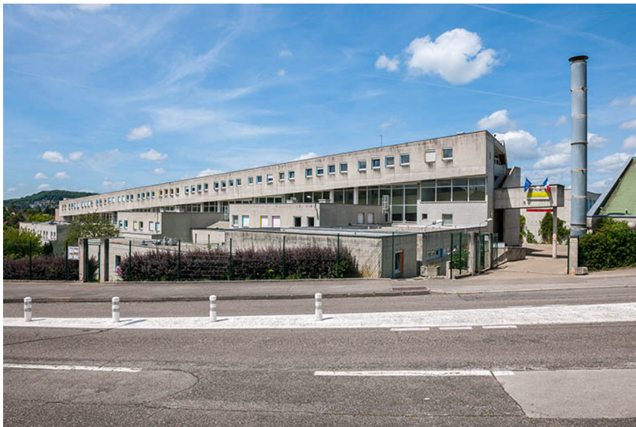
Vue générale depuis la rue Charles Ramey
