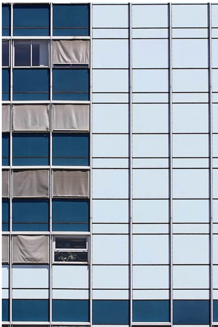
Bâtiment principal, détail.
