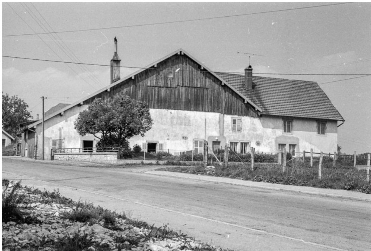
Ferme cadastrée 1973 ZE 31a : façade antérieure.
