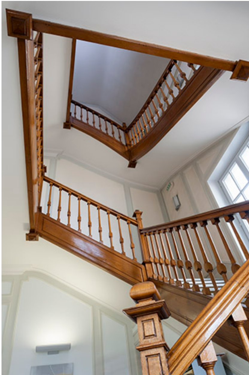
Hall d'entrée : cage d'escalier, vue en contre-plongée.
