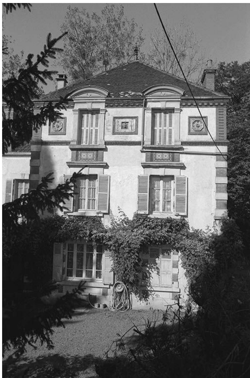
Façade sud du logement patronal.
