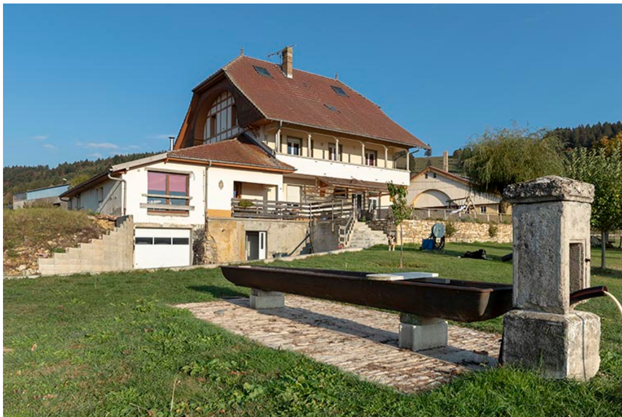
Façades postérieure et latérale gauche.
