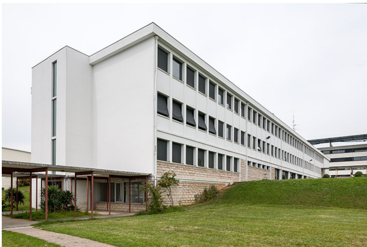
Externat : ancien bâtiment, pignon sud.
