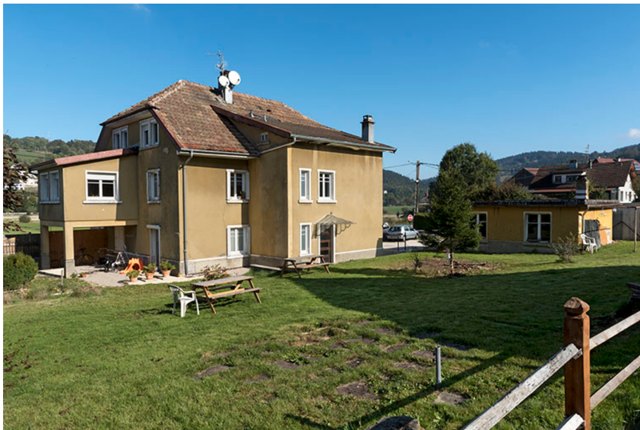
Façades postérieure et latérale droite.
