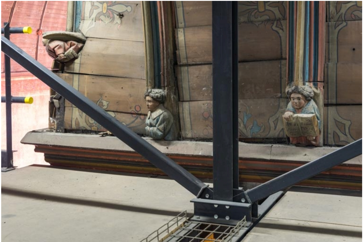
Angle nord-ouest, mur ouest : deux anges.
