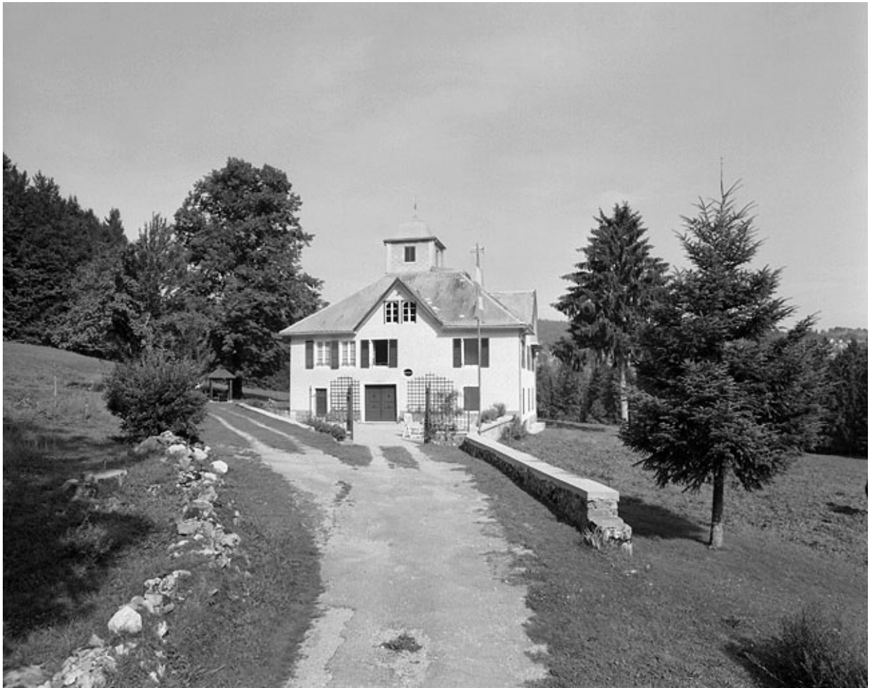
Façade antérieure, vue éloignée.
